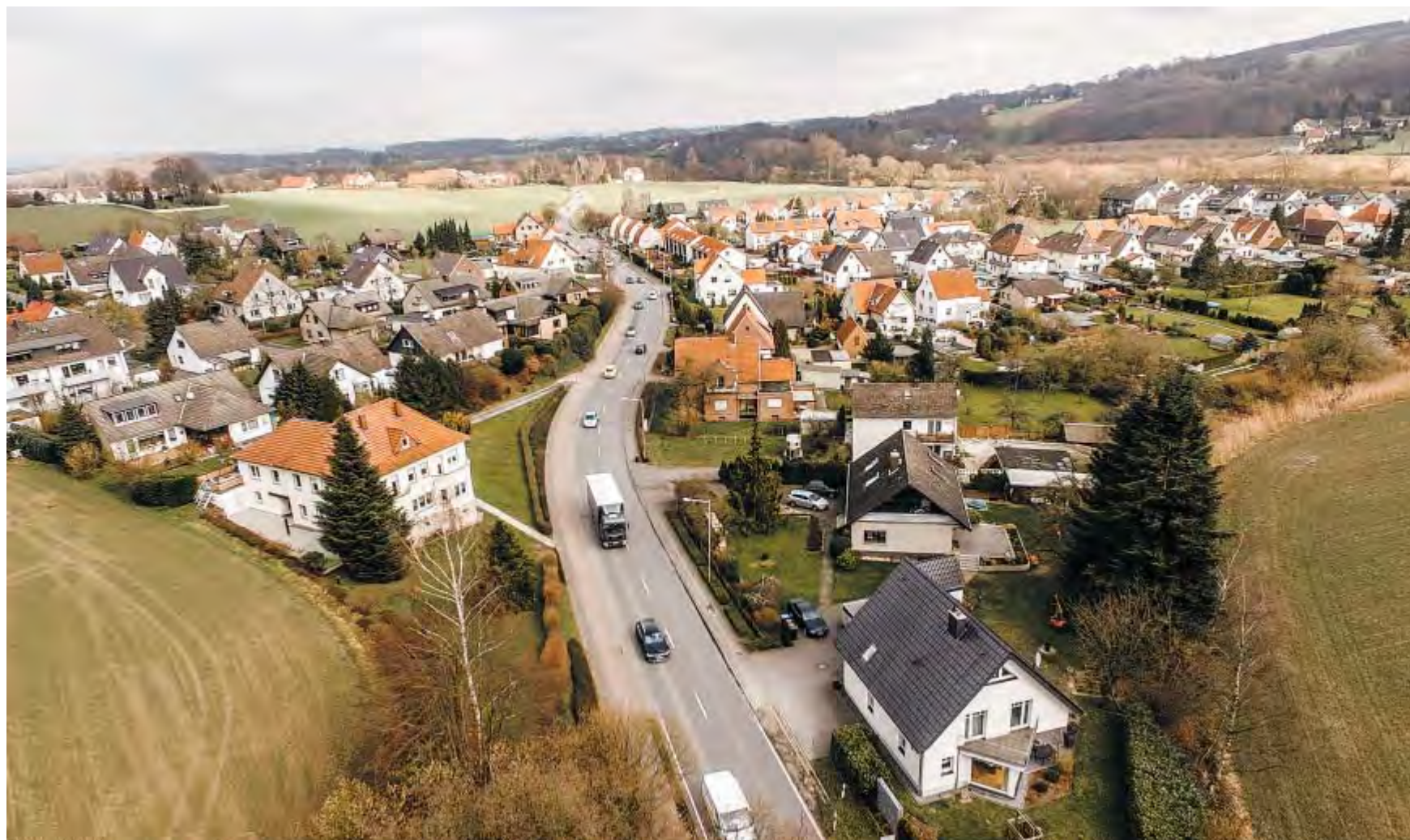
Täglich sind hier 15.000 Fahrzeuge unterwegs: Anfang April wird die B 239 zwischen Kirchlegern und Herford saniert.
