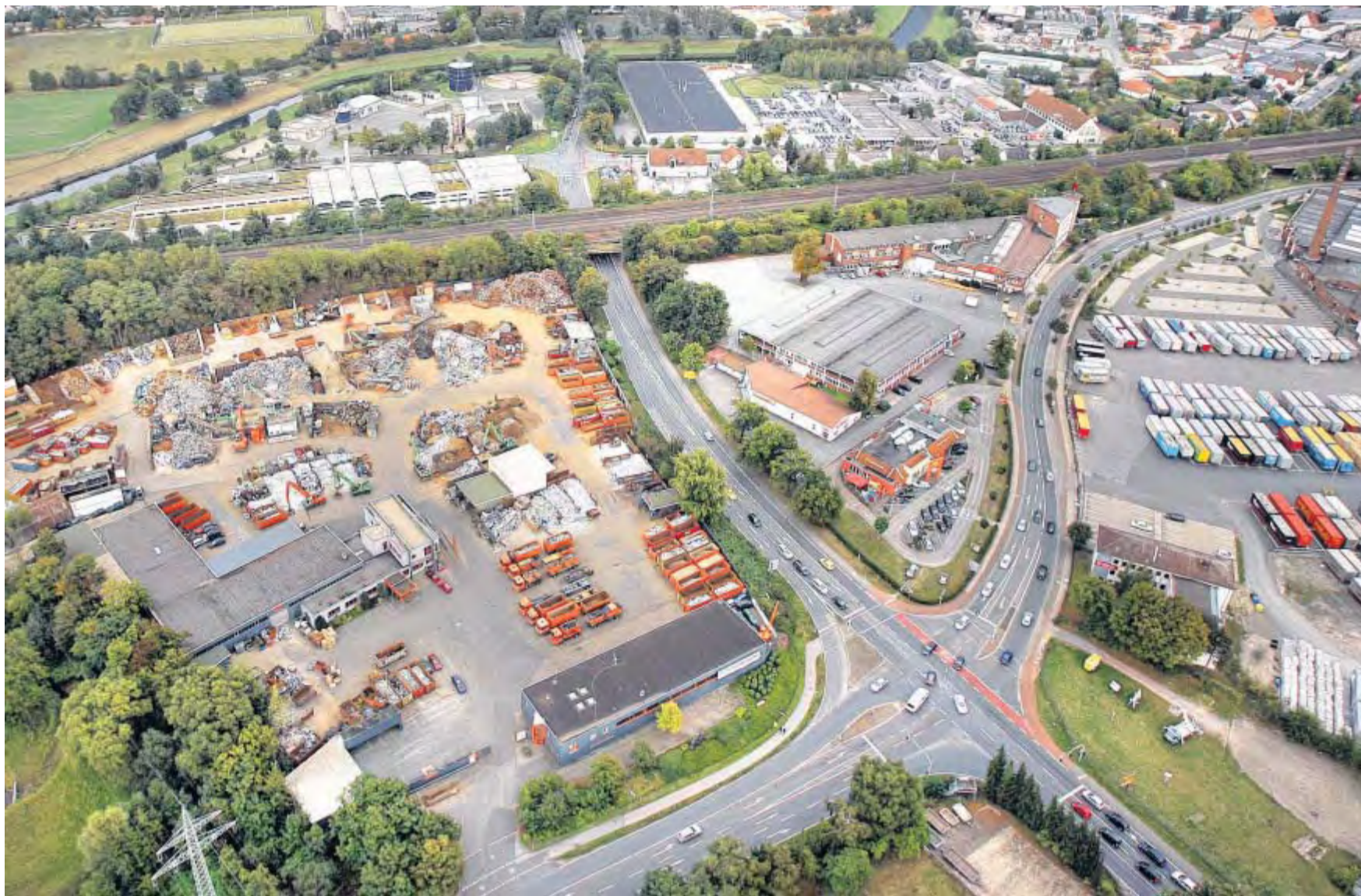
Knoten- und Knackpunkt Bündler Straße: Mit dem Ausbau der Umgehungsstraße soll sich auch das Bild der Kreuzung verändern. Unter anderem sind für den aus Richtung Autobahn kommenden Verkehr neben einer Geradeausspur und einem Rechtsabbiegestreifen zwei Linksabbiegespuren geplant.
