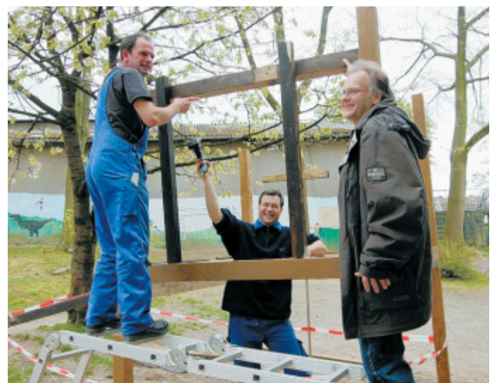
Am Werk: Paul Evans, Daniel Kuckuck und Jörg Kurrek arbeiten am Neubau des Spielhauses im Hiddenhauser Kindergarten. FOTO: DOHNA
